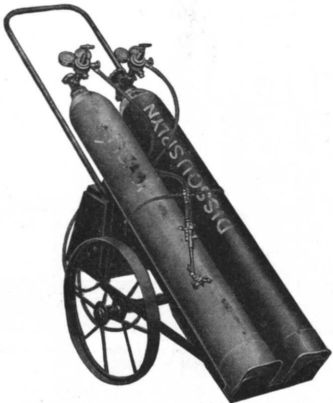
Obr. 4. Pojízdné svářecí zařízení s dissousplyinem a kyslíkem.
