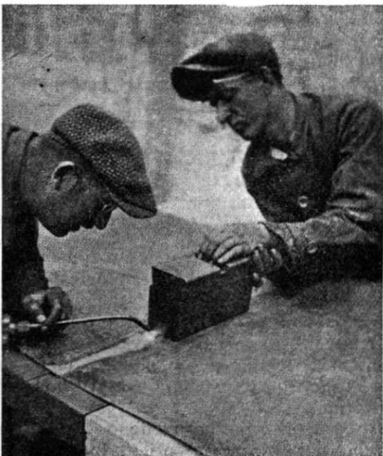
Obr. 65. Sváření slabých plechů.
